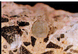
Vyztuž pod ochranou expanzního tmelu po namáčecích zkouškách
